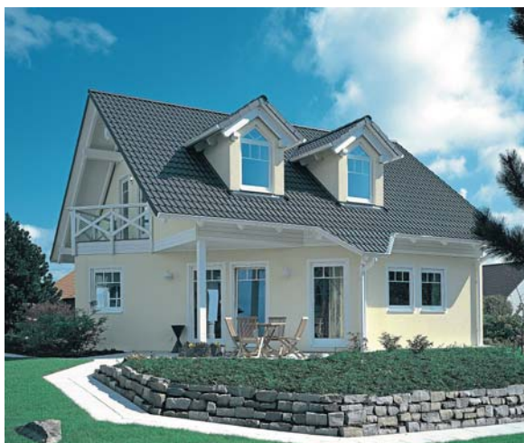
Ein Profi sollte regelmäßig das Dach in Augenschein nehmen. Foto: Braas
