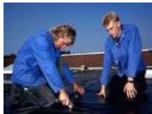
Man lernt, wie eine Naht verschweißt wird
